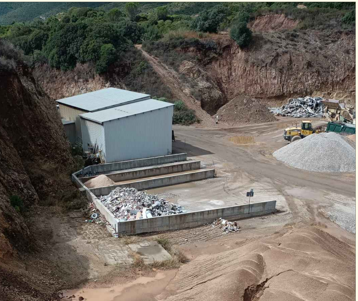
6 vista vasche impianto di prima pioggia e box ricovero mezzi
